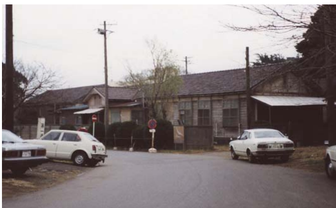
写真1. 肺癌研究施設の建物-2 ①の中央バラック小屋側から見た時の写真
