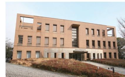
附属図書館亥鼻分館新館
